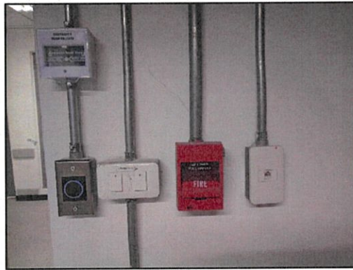
รูปที่ 34 ชุดแจ้งเหตุแบบใช้มือพร้อมอุปกรณ์ส่งสัญญาณโทรศัพท์
