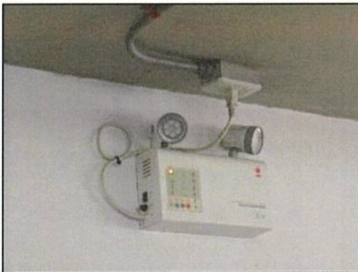
รูปที่ 38 ไฟส่องสว่างฉุกเฉิน
