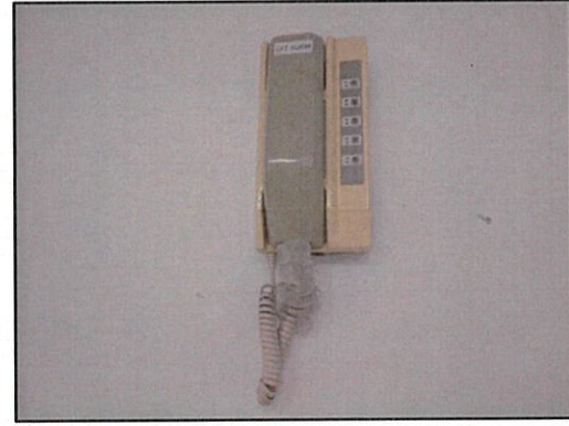
รูปที่ 34 ชุดแจ้งเหตุแบบใช้มือพร้อมอุปกรณ์ส่งสัญญาณโทรศัพท์
